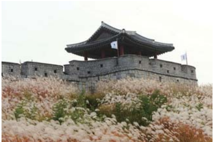
화서문 일대를 지휘하던 서북각루 西北角樓
